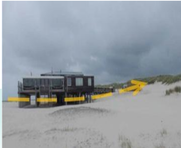
Plaatsing op palen
